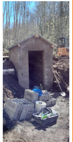
Les installations techniques du captage de Salamou en cours de construction
